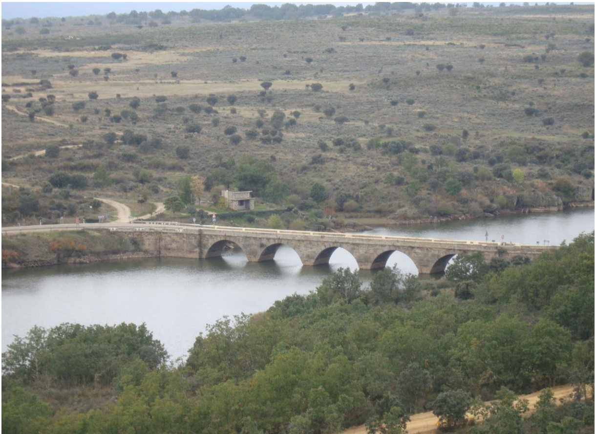
Vista del Puente Tera, con el refugio del antiguo Coto de Pesca.
